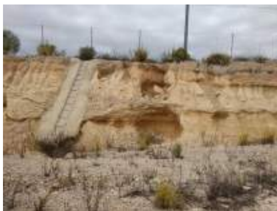
Figura 7: Ciclo-senderos vehiculares (detalle de erosión de pista y márgenes).
