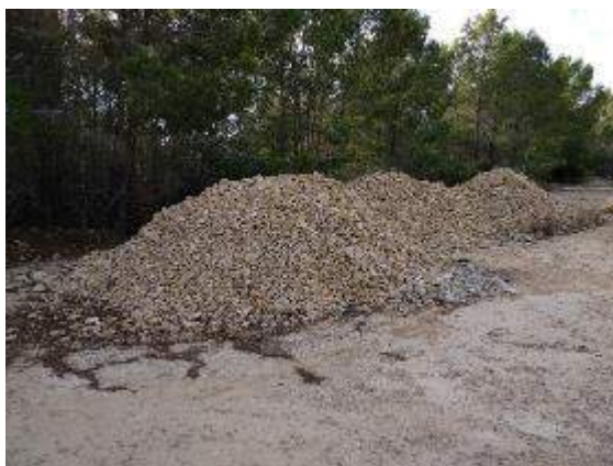
Figura 16: Escombros 06, (dimensiones aproximadas 15 x 3 x 2 m).
