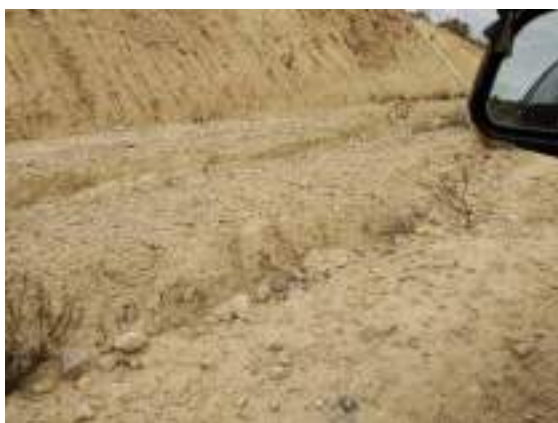
Figura 7: Ciclo-senderos vehiculares (detalle de erosión de pista y márgenes).
