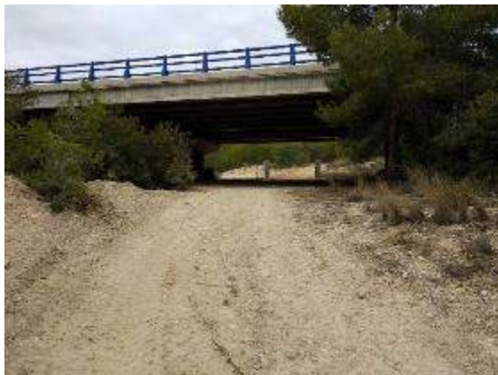
Figura 35: Situación actual de la obra de paso 02.
