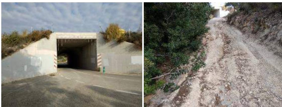
Figura 36: Situación actual de la obra de paso 03.
